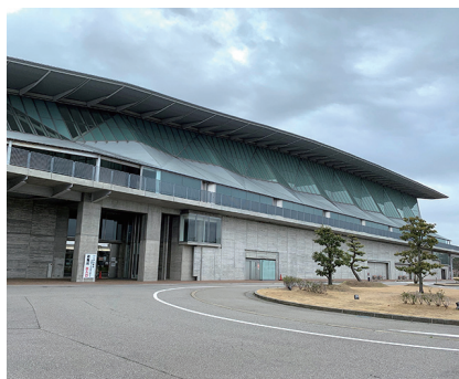
いしかわ総合スポーツセンター
